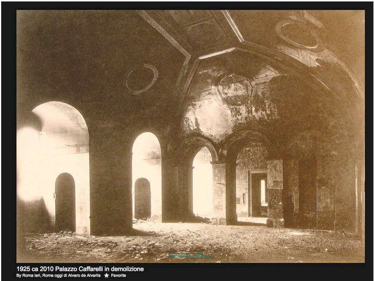
Fig. 18. Il Palazzo durante la demolizione.
