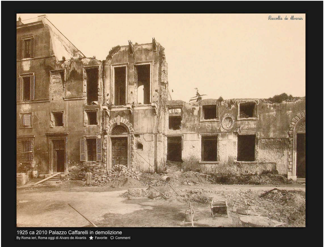
Fig. 20 Il Palazzo durante la demolizione.
